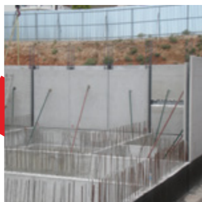
4 η Φάση Τοποθέτηση Τοιχίων Υπογείου
