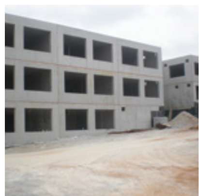
6 η Φάση Τοποθέτηση Υπόλοιπων Ορόφων
