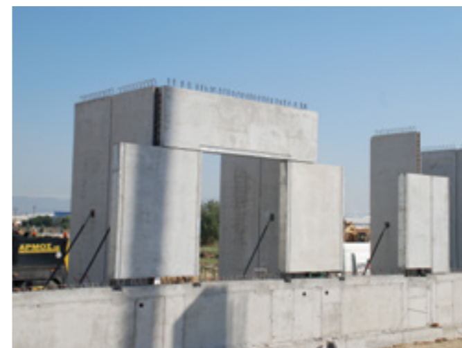
Aldi, Τοιχία επένδυσης ραμπών φορτοεκφόρτωσης
