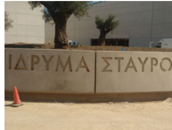
Τοιχία εμφανούς σκυροδέματος με ανάγλυφη επεξεργασία
