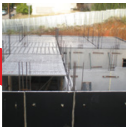
5 η Φάση Τοποθέτηση Πρόπλακων Υπογείου & Πραγματοποίηση Υγρών Συνδέσεων
